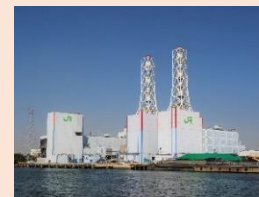
川崎火力発電所
