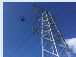
ドローンを活用した送電線検査
