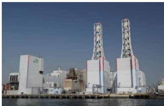
川崎火力発電所
