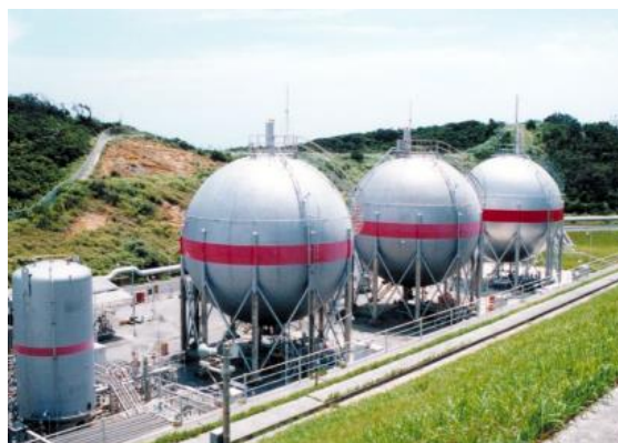
JAXA種子島宇宙センター 液化水素貯蔵供給所
